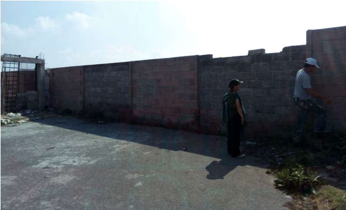
Acceso cerrado a Geovillas de Terranova sobre la calle Lago Catemaco. Fuente: Anatali Cruz, Geovillas de Terranova, 12 de marzo de 2017.
