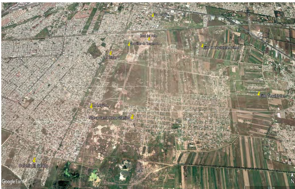
Imagen 16. Inicio de la edificación de los conjuntos urbanos
