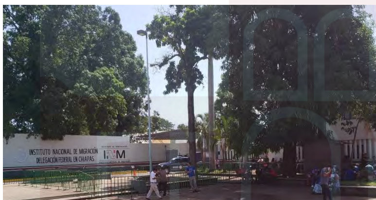
Imagen 6: Fachada de la estación migratoria Siglo XXI en Tapachula, México. 30 de julio 2019.
