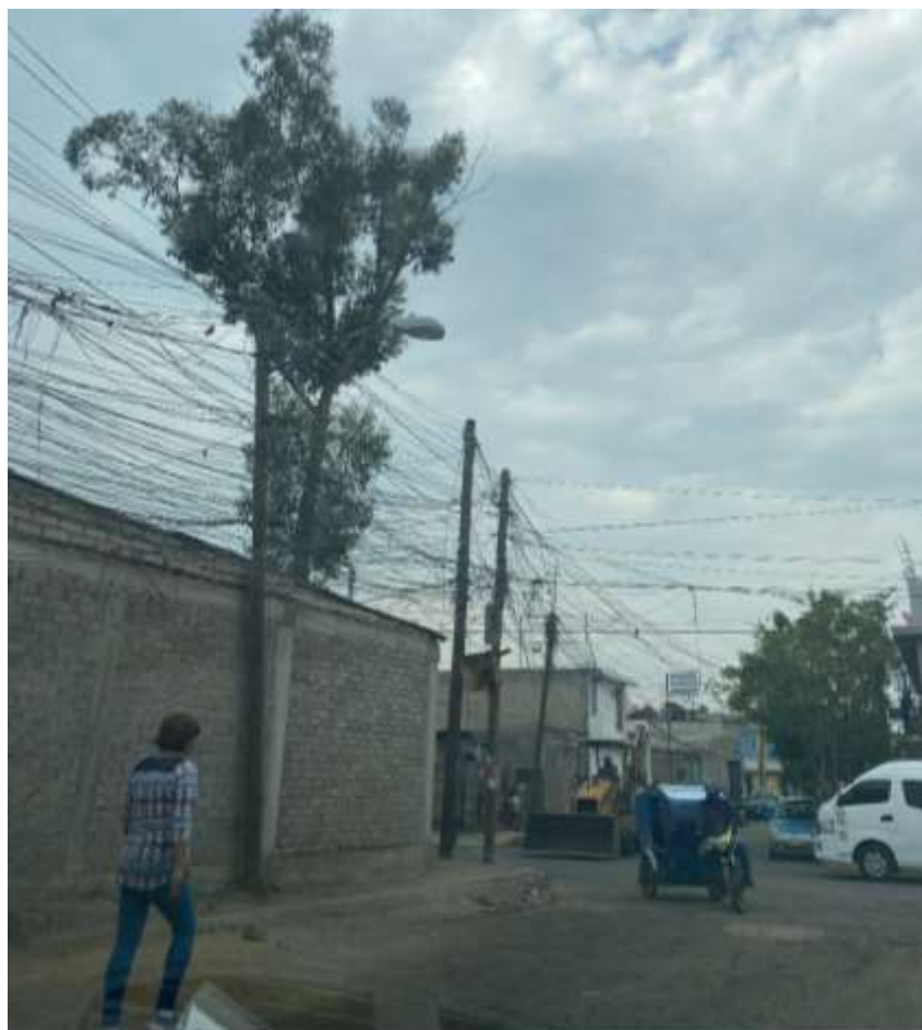
Imagen 3.6. Fotografía del área periurbana sin infraestructura. Tomada por Omar Patiño Carapia
