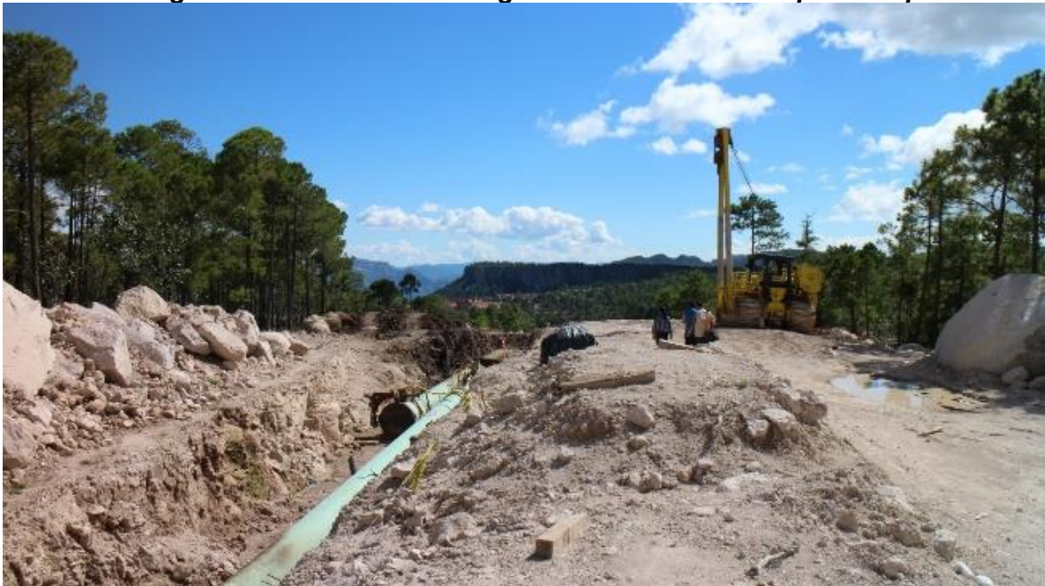
Fotografía 5. Construcción del gasoducto El Encino-Topolobampo
