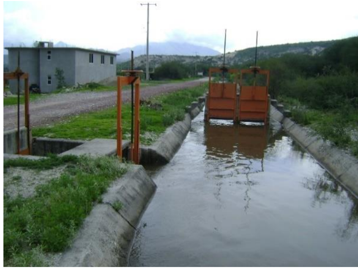
Fotografía 2.3 Sistema de riego en la comunidad
