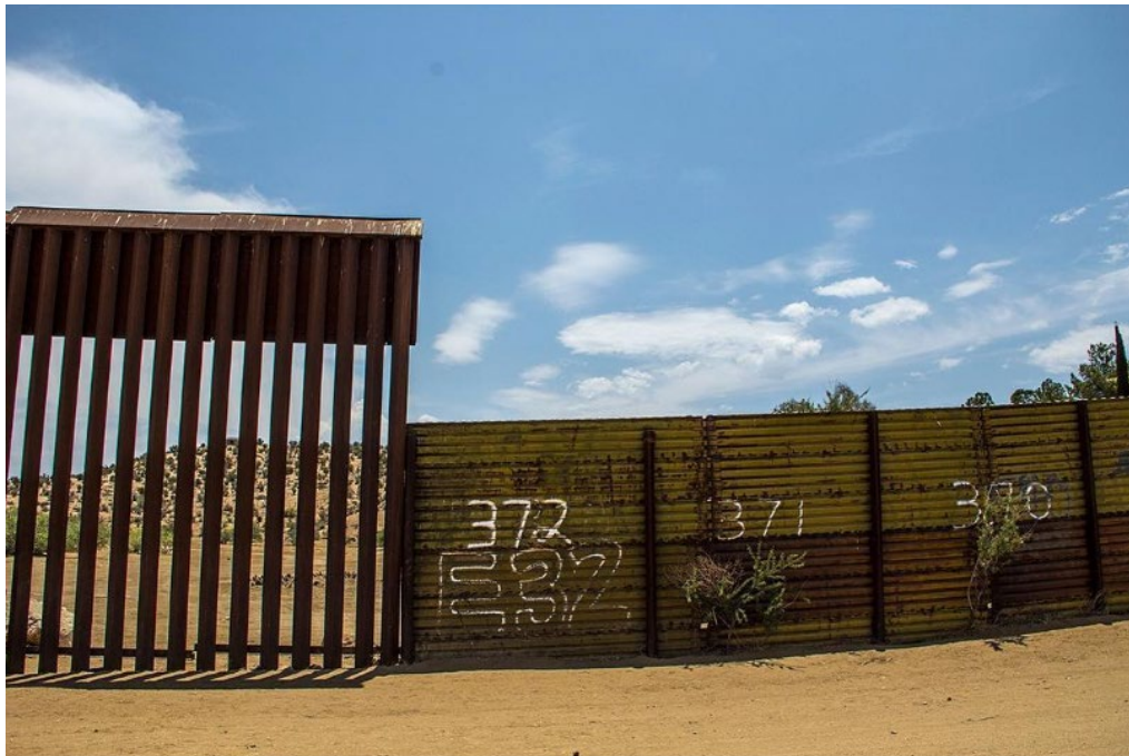
Ilustración 1. Sección fortificada del muro junto a una sección antigua (Martínez, 2016)
