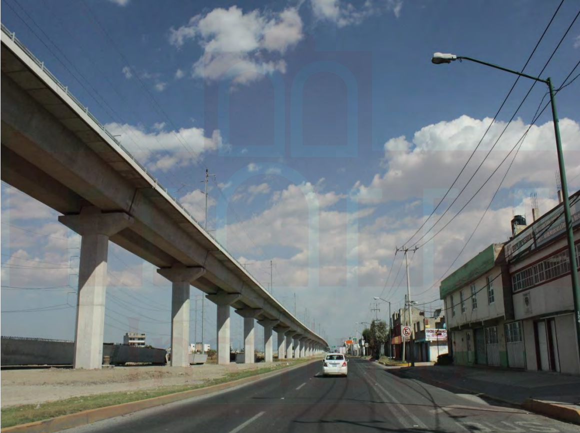
Jimena Chávez. San Mateo Atenco, Estado de México. 11 de marzo, 2018. Vía elevada del Tren Interurbano México-Toluca sobre avenida Solidaridad en San Mateo Atenco, Estado de México.
