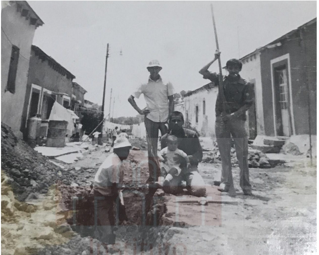
“Construcción del drenaje en el barrio Las Calles”, archivo personal de Antonio Pérez Sánchez, 1980 aproximadamente.
