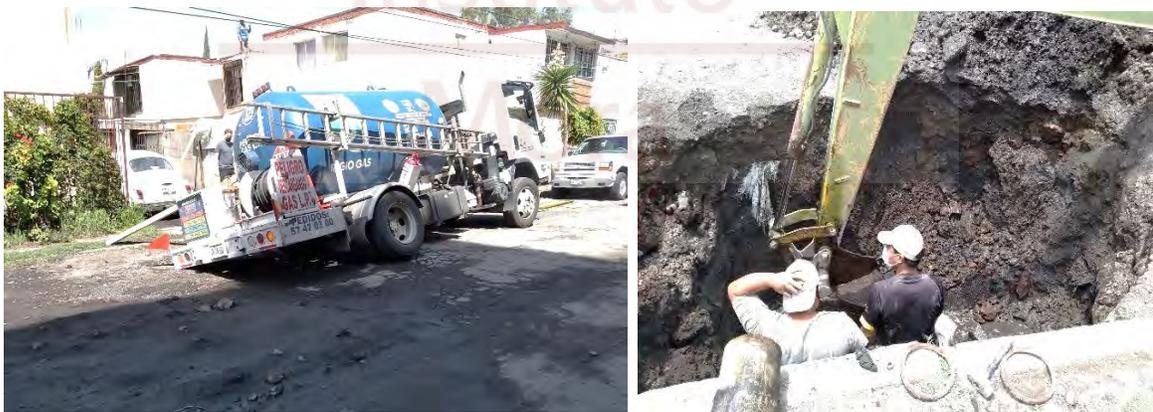
*Foto 5-7 Socavón en Villa Centroamericana, en julio de 2020, Imágenes tomadas de X “Hundimiento de pipa de gas, el suelo está muy blando”.*
