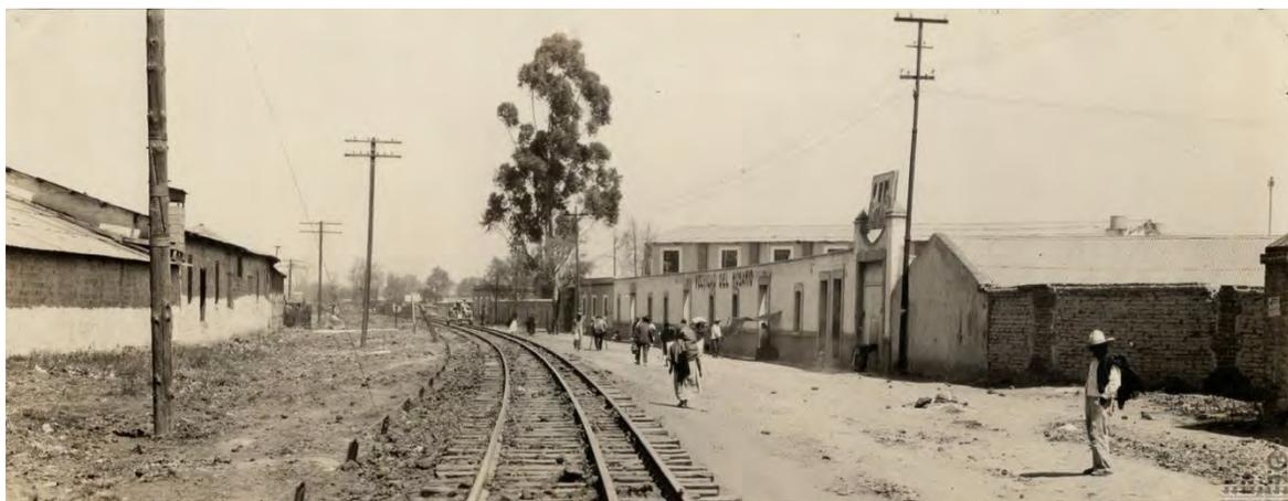
FUENTE: A-2-3300-490: Detalle de vía, curva y tangente al Sur, al salir del Patio de Buenavista. Casas que invaden el Derecho de vía a uno y otro lado de la vía. Caseta dos pisos tepetate y tabique para enclavamiento en el cruce con la Calzada Nonoalco, 1926, Fondo FNM, Sección de Comisión de Avalúo e Inventarios, Secretaría de Cultura, CNPPCF, CEDIF.
